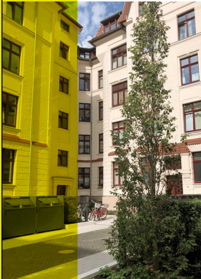
Die Fassaden und Außenanlagen im Quartier Spielhagenstraße und Heidornstraße erstrahlen nach umfangreichen Sanierungen im neuen Glanz.
